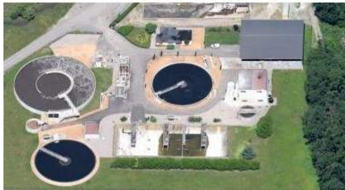
Station d'épuration de Pont du Château.
