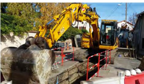
Voici quelques chiffres sur cet important chantier : 360 ml de canalisation « eaux usées » posés, 40 branchements particuliers repris et mis aux normes. Sur le plan comptable, la réalisation de la partie « eaux usées », la reprise des voiries, les suivis techniques, les contrôles seront financés par le syndicat à hauteur de **171 000 € H.T.** la commune ayant pour sa part à sa charge des travaux annexes sur le réseau d'eaux pluviales pour un montant de **18 000 € HT.**
