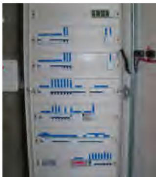
15 ans de fonctionnement et de nombreuses évolutions, l'installation électrique de la salle de sports méritait une mise à niveau. Dans ce cadre l'armoire électrique a été totalement remplacée. Des petits aménagements complémentaires ont également été apportés. Coûts : 7 728.07 € TTC.
